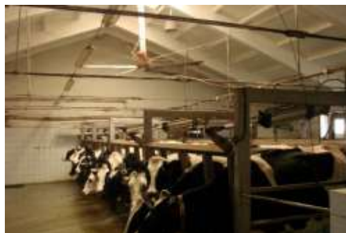
Fot. 2. Wentylator sufitowy w hali udojowej
