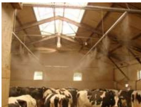
Fot. 3. Wentylator sufitowy i urządzenie do zamgławiania powietrza w poczekalni
