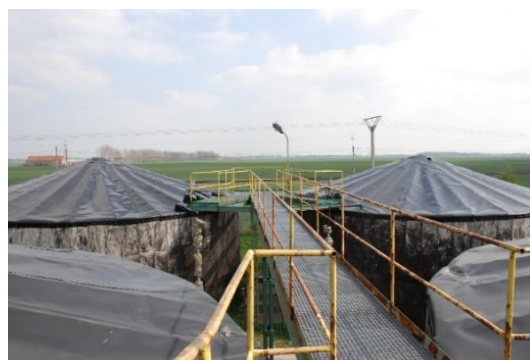
Fot. 2. Przykrycie zbiorników na gnojowicę (J. Walczak).
